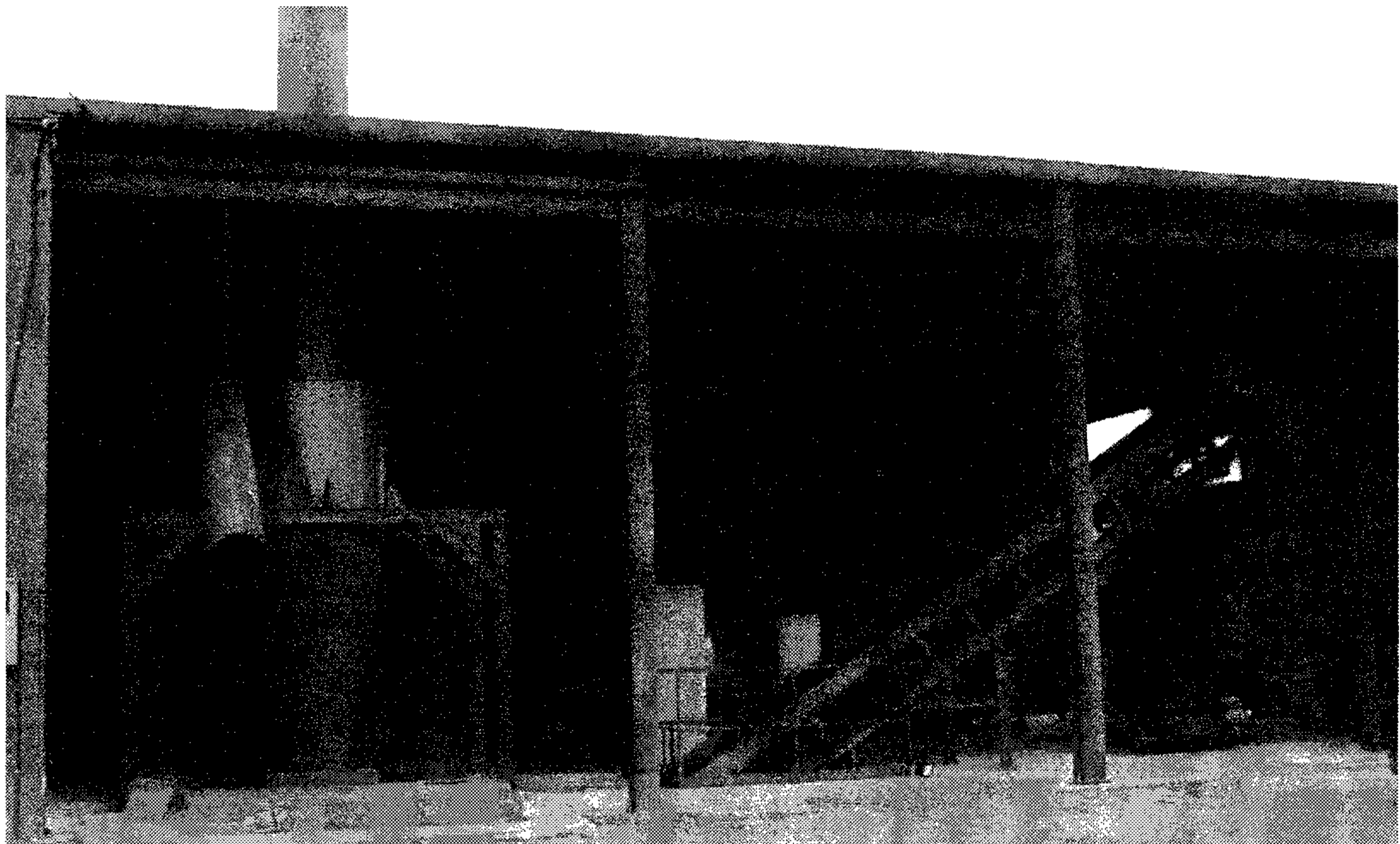
그림 67 완성된 TMR 플랜트의 통합시스템의 내부전경 1
