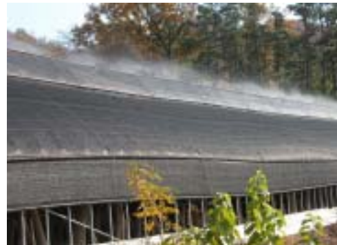
그림 123. 재배사 상부 분무로 기화열 이용한 온도하강과 동시에 습도상승 효과 (천안 황성태 씨 농장)
