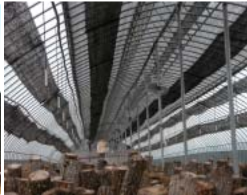
그림 108. 차광, 천창, 환풍 고려한 재배사 내부(천안 황성태씨 농장)
