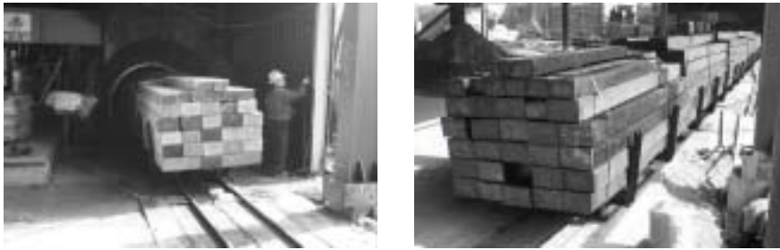
<그림 4-3>. 철도 침목 실대재의 크레오소오트유 현장 주입 (좌: 주약관내 침목 투입, 우: 주입 후 침목 반출)
