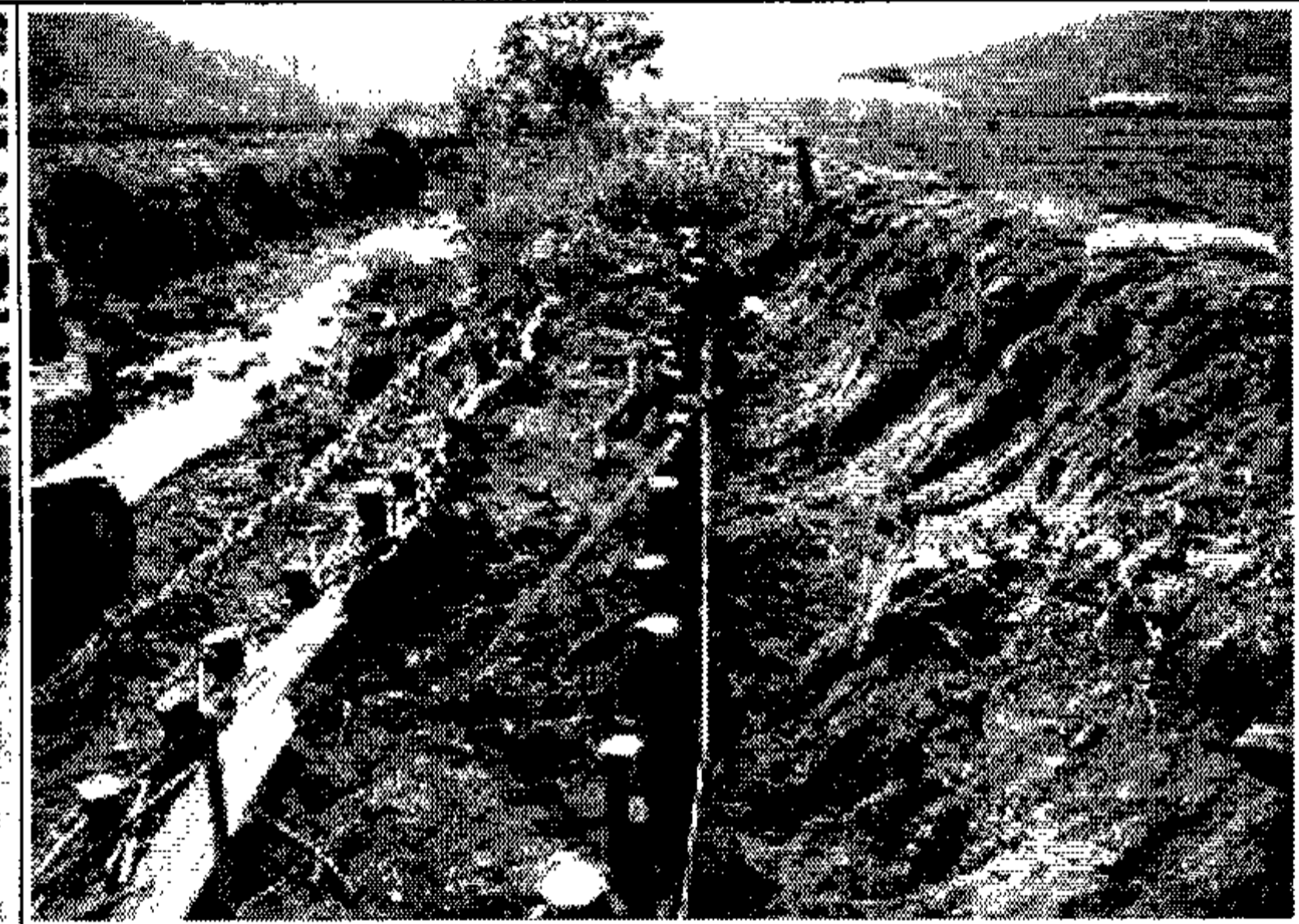
3단 말뚝 설치
