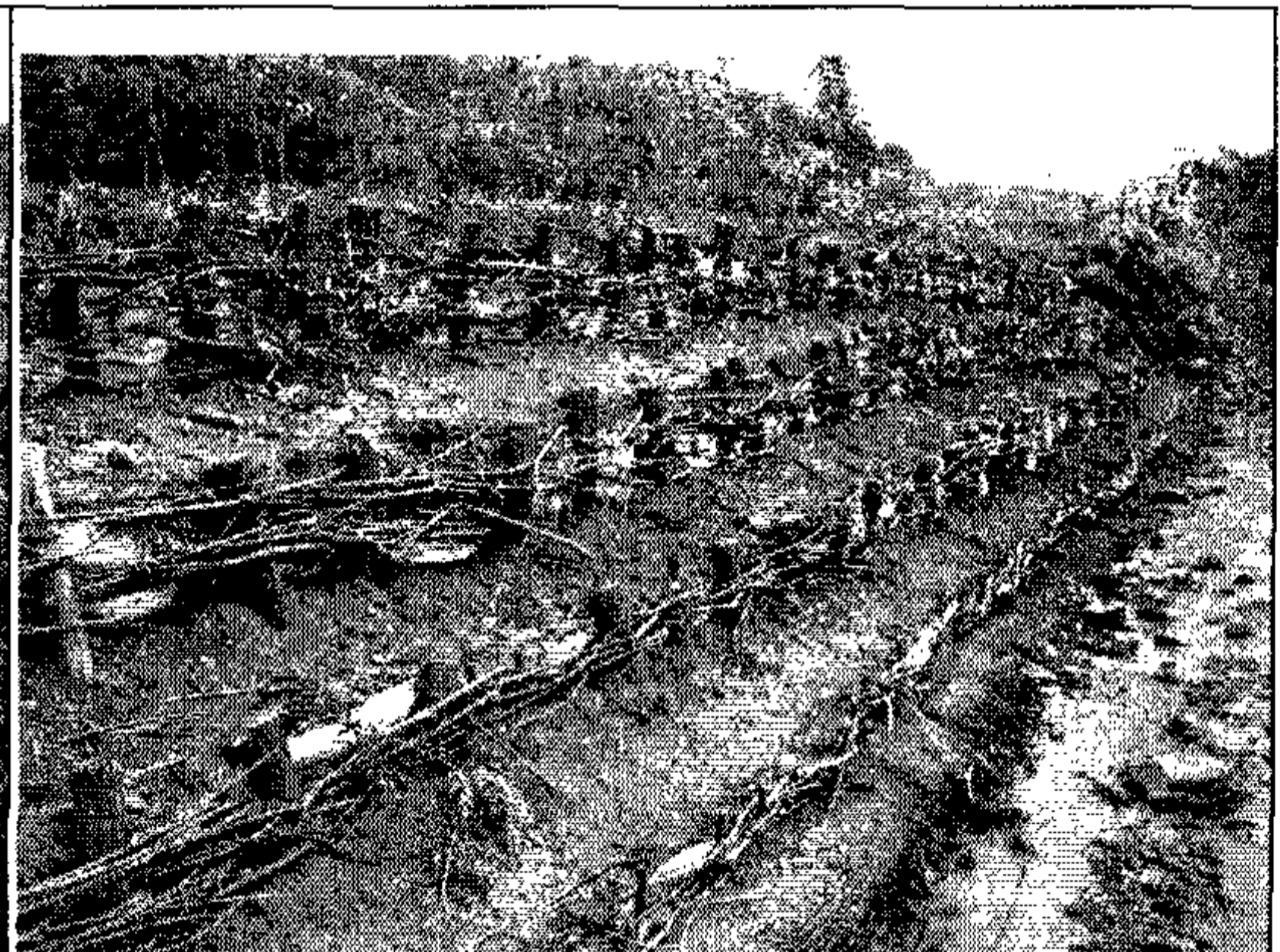
급경사지역 시공 후 모습(근경)
