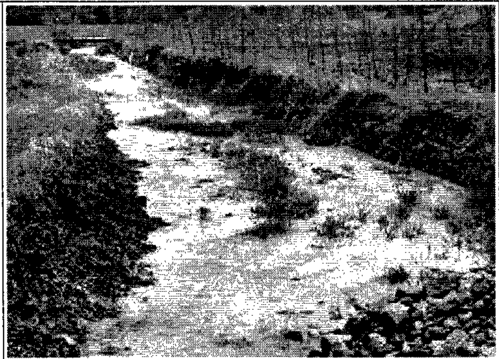
시공 전 모습
