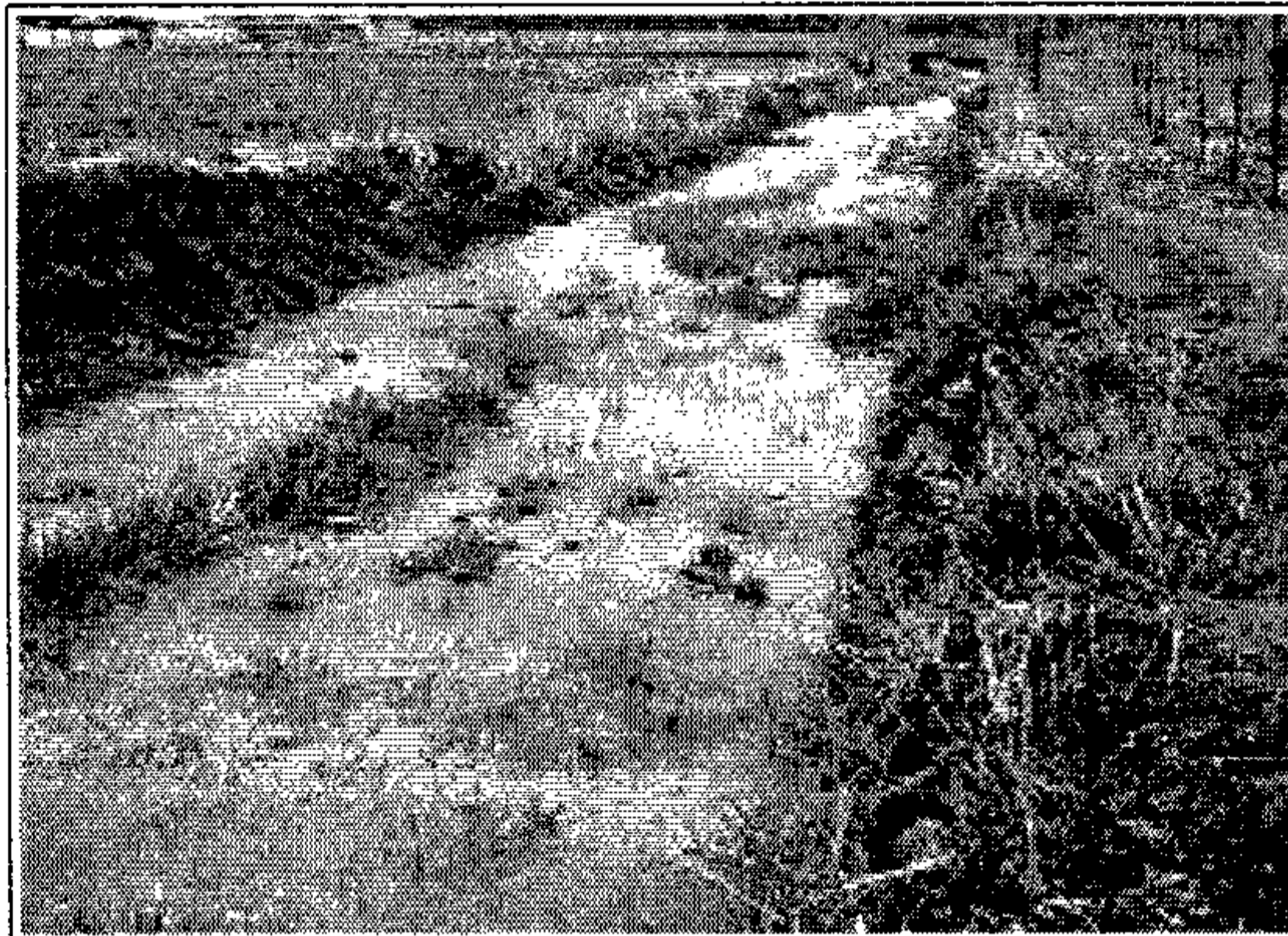
시공 전 모습
