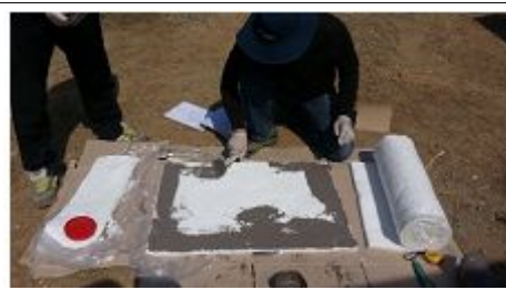
내화 단열재 세라크울 설치 모습
