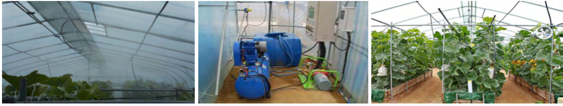
그림 13. 포그냉방(좌), 포그냉방용 에어컴프레샤(중) 및 공기순환팬(우) 가동
