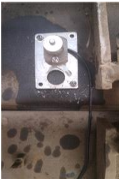
그림 176. 뒷부분 설치 확대 사진
