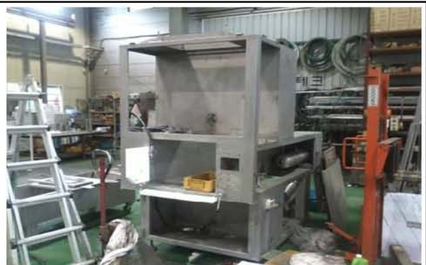
flame 제작(용접) 조립
