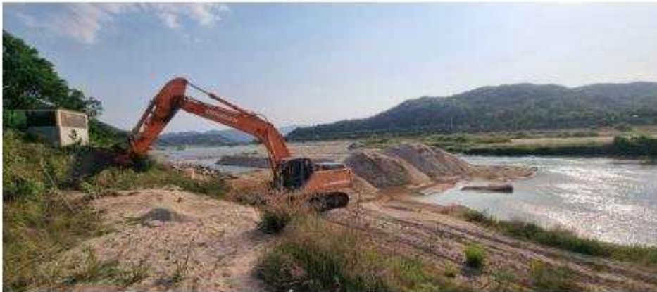
합천군과 한국농어촌공사가 가뭄 대비 농업용수 공급을 위해 지난달 합천 읍주변에서 하천 바닥에 대한 굴착작업을 하고 있다./경남도/
