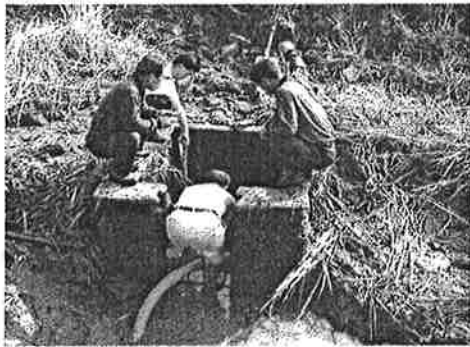
(c) 토사유입방지 구조물(도로 초입)
