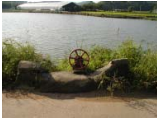
사진 3.1.1 토오크(Torque) 측정대상 사통수문 모습
