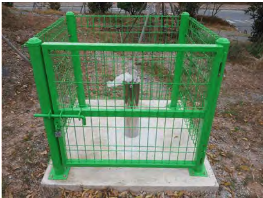
(a) 관측공 굴착, 기초, 보호시설 설치
