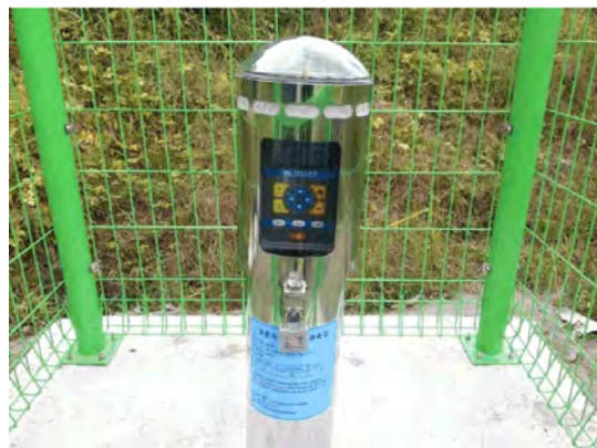
(d) 관측망 설치 완료
