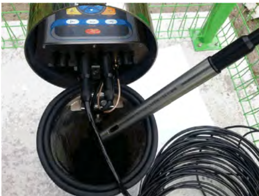
(c) 관정내장형 관측장비 설치
