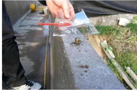
2) 접촉핀 설치 (에폭시 접착)
