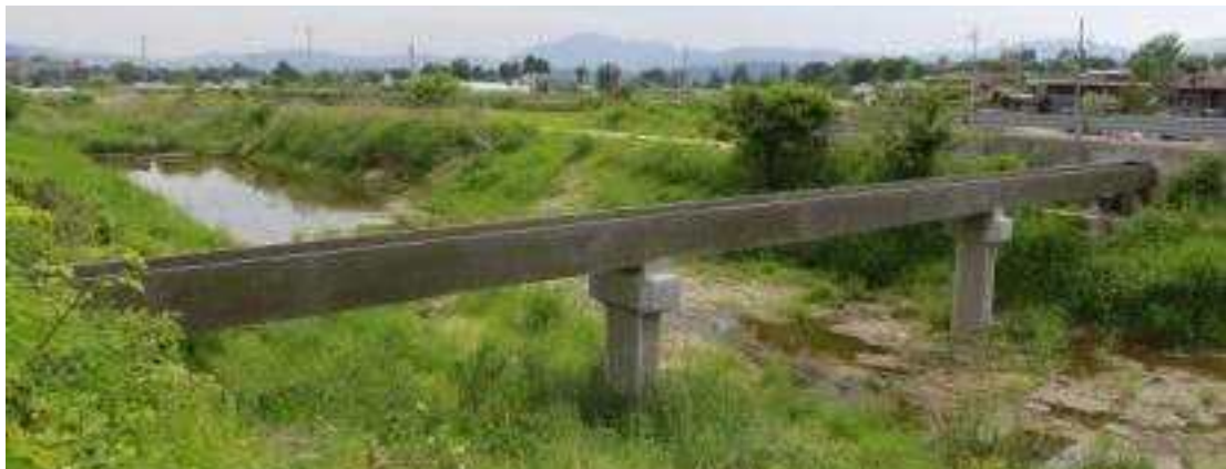
사진 6.12 리모델링 후의 수로교
