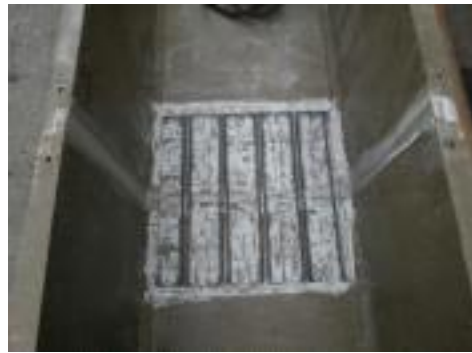
4) 연결용 철근 설치
