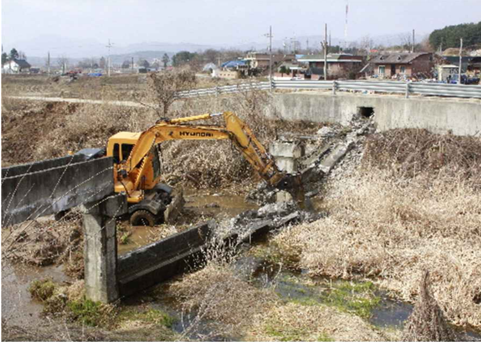
사진 6.6 콘크리트 수로교 철거 광경 ( 0.6 m 3 급 백호 )
