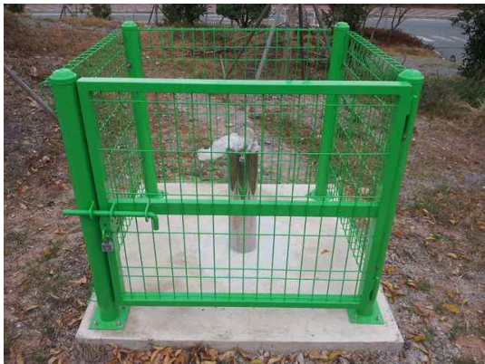
(a) 관측공 굴착, 기초, 보호시설 설치
