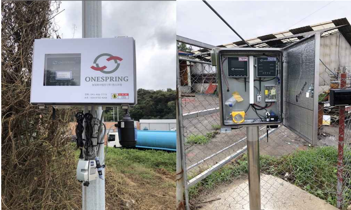
그림 86. 자원 에너지화 시설에 IoT 센서 및 통신 모듈 설치
