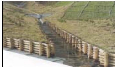
그림 3-1-2. 목제 유로공의 시공 후의 모습
