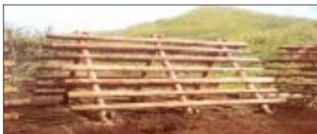
그림 3-1-5. 목제 방풍편책의 시공 후의 모습
