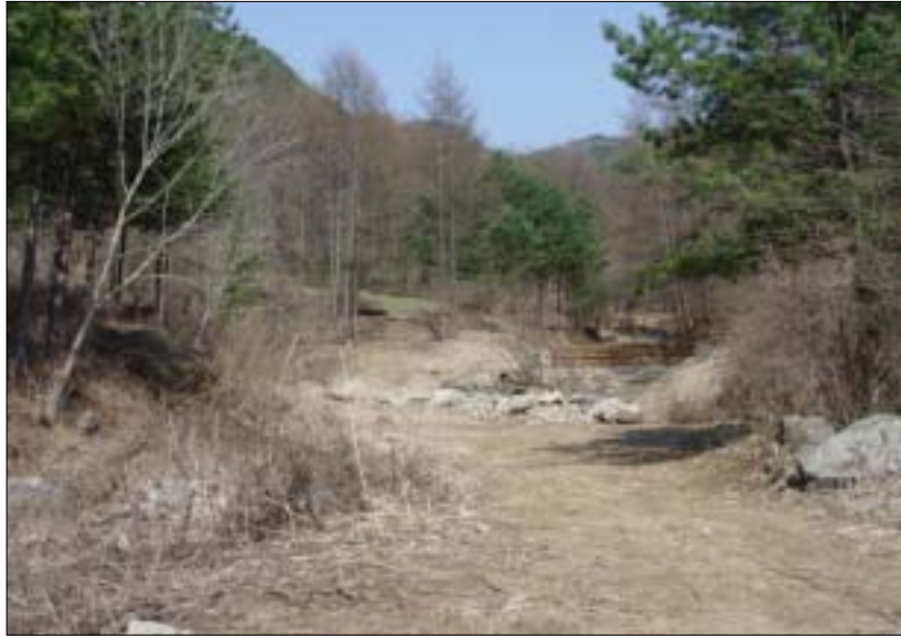
그림 3-3-3. 목제 사방댐 시공지의 전경
