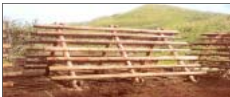
그림 3-1-5. 목재 방풍편책의 시공 후의 모습
