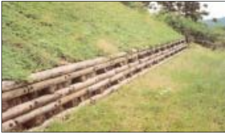
그림 3-1-3. 목재 흙막이의 시공 후의 모습
