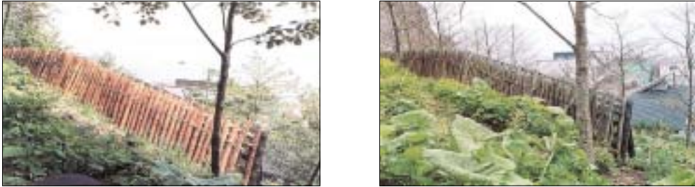
그림 3-1-6. 목재 낙석방지책의 시공 후의 모습
