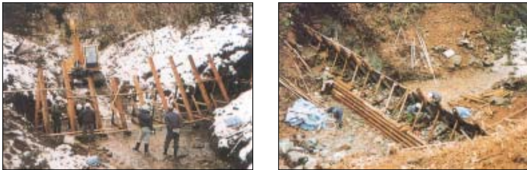
그림 3-10-9. 시공 중인 목제사방댐
