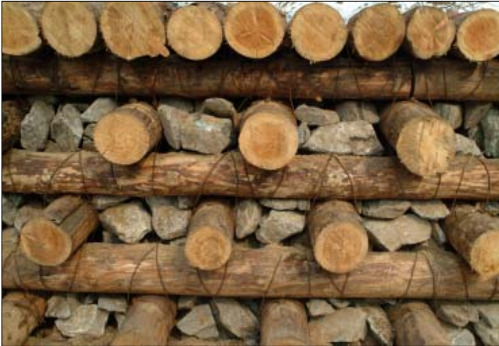
그림 3-9-8. 강원대학교 학술림에 설치된 목재사방댐 Type II
