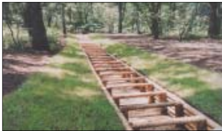
그림 3-1-2. 목제 유로공의 시공 후의 모습
