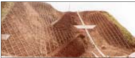
그림 3-1-4. 목제 격자틀붙이기의 시공 후의 모습
