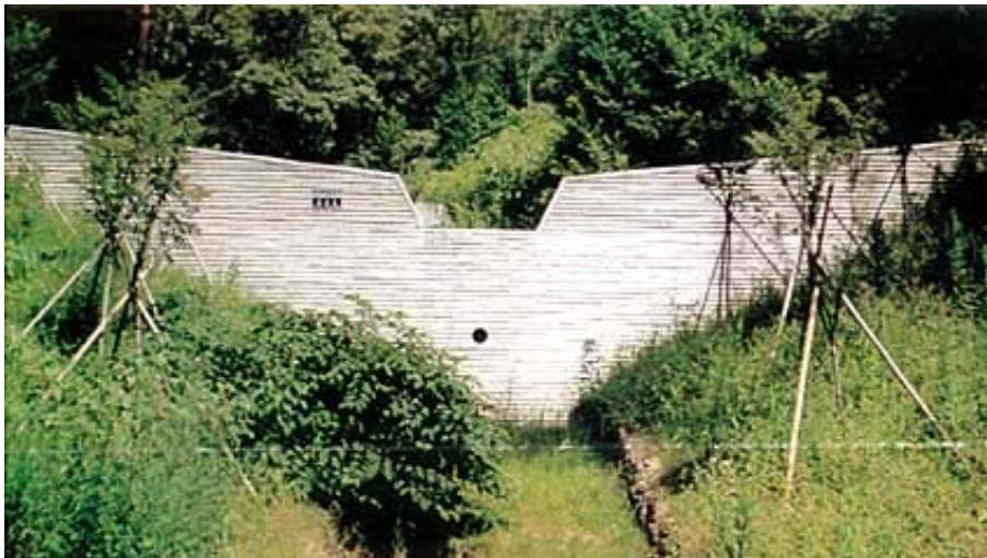
그림 3-1-12. 수경공의 시공 후의 모습
