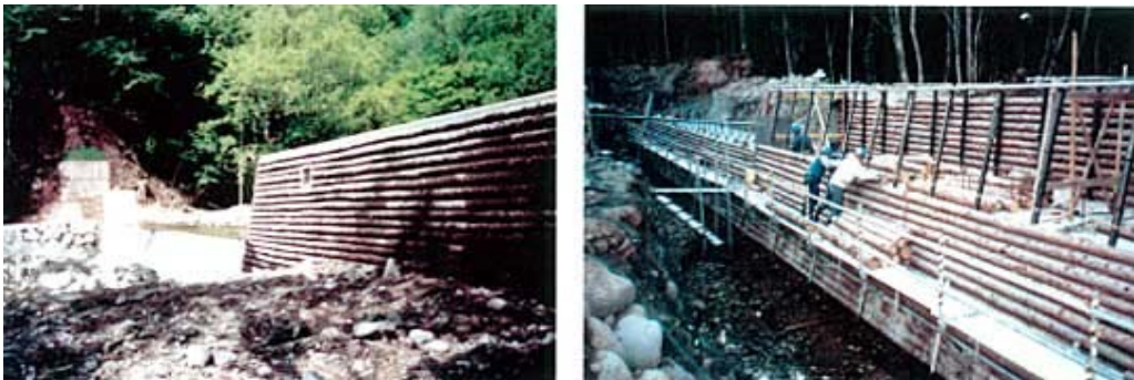
그림 3-1-8. 콘크리트 댐 잔존형 틀의 시공 모습
