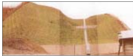
그림 3-1-4. 목제 격자틀붙이기의 시공 후의 모습
