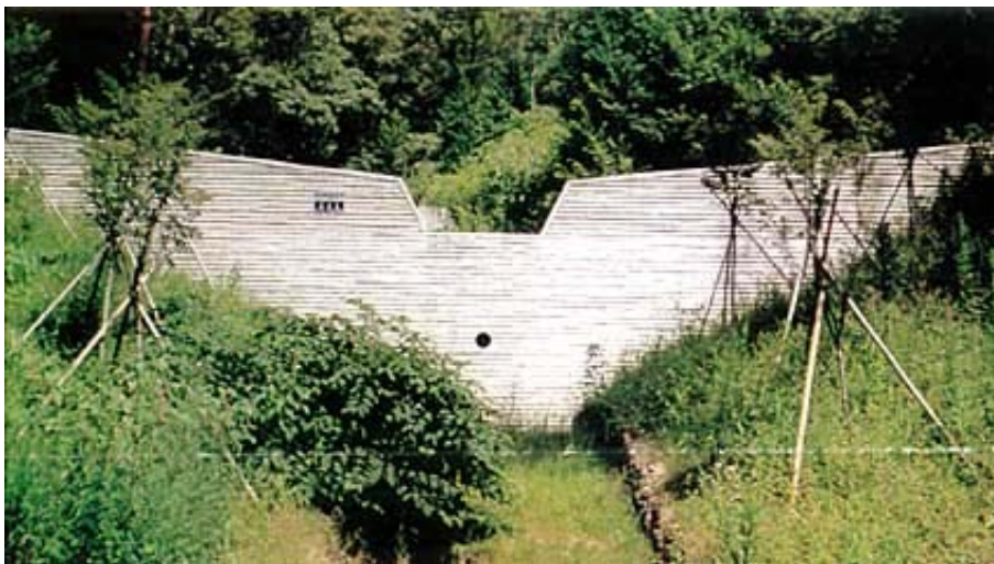
그림 3-1-12. 수경공의 시공 후의 모습
