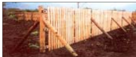
그림 3-1-5. 목재 방풍편책의 시공 후의 모습
