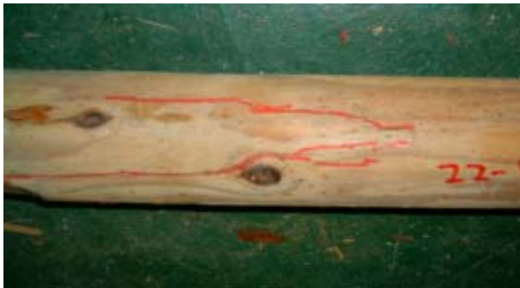
그림 3-8-24. 방부 처리 원주목의 파괴형상(LC-3)
