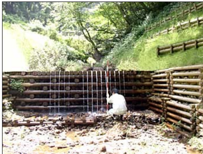
그림 3-1-14. 목제 낙차공의 시공 후의 모습
