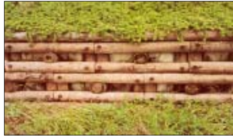
그림 3-1-3. 목제 흙막이의 시공 후의 모습
