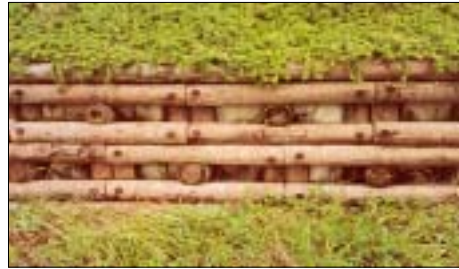
그림 3-1-3. 목재 흙막이의 시공 후의 모습
