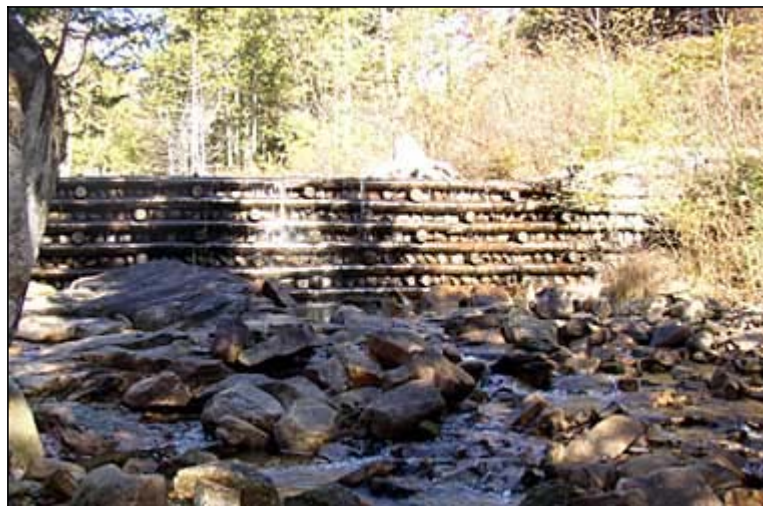
그림 3-1-18. 목제틀 낙차공의 시공 후의 모습
