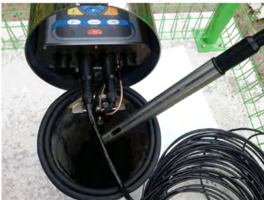
(c) 관정내장형 관측장비 설치
