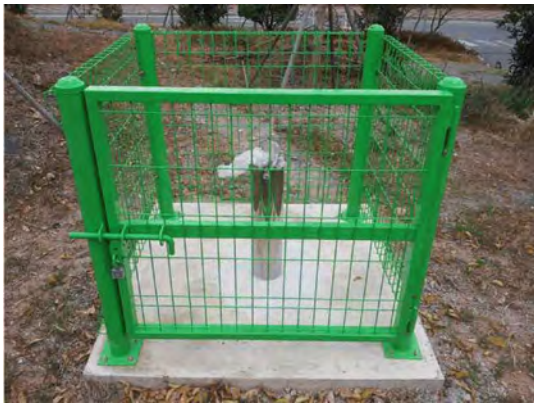
(a) 관측공 굴착, 기초, 보호시설 설치
