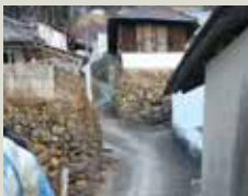
경사지 도로 현황
