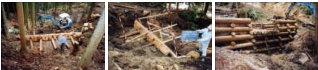
그림 3-1-18. 목재바닥막이 내부에 목탄을 충전한 자루를 채우는 장면
