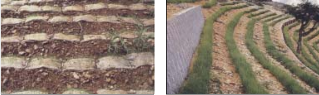
그림 3-1-5. 일본의 식생자루 도입상황(좌)과 시공 후 식생 생육상태(우)
