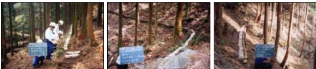
그림 3-1-19. 산복 비탈면에 목책 안쪽에 목탄을 충전한 자루를 시공하는 장면
