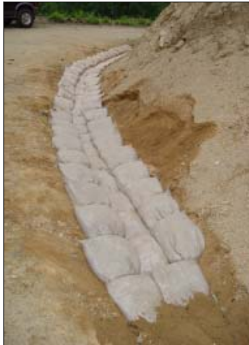
그림 3-4-30. 측구 시험구 1, 2 및 3의 시공 후 전경
