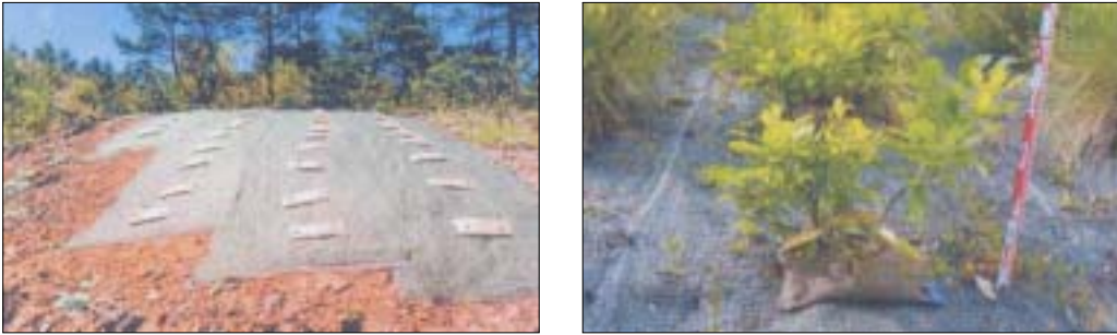
그림 3-1-10. 다기능 휠터로 제작한 식생자루의 시공직후(좌)와 2년 후의 상황(우)
