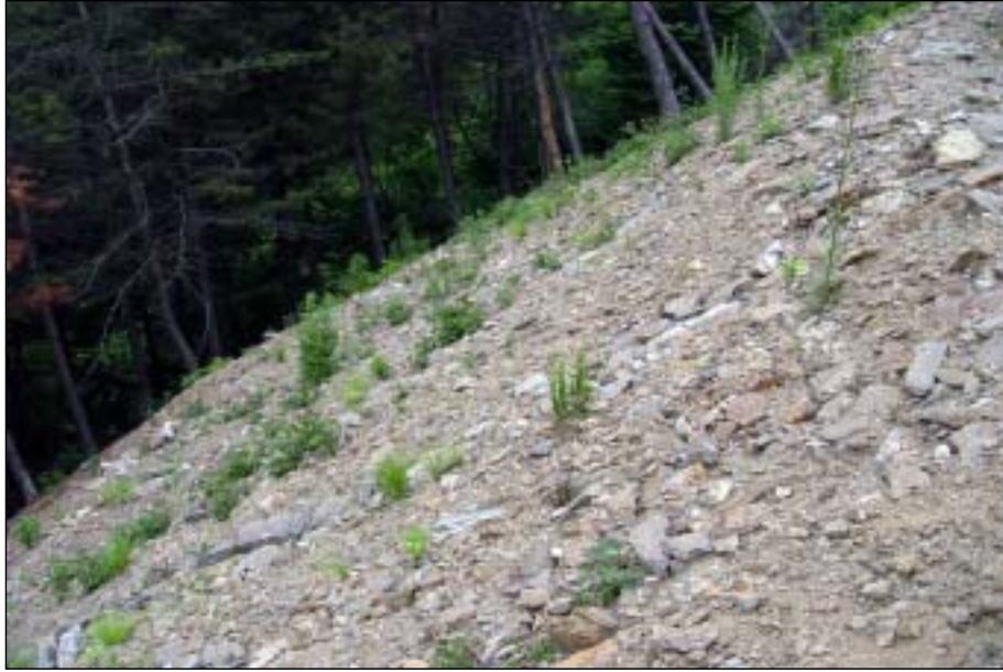
그림 3-4-24. 환경사지 1의 시험구 조성 이전 모습(임도 시공시 채취된 암석 파편들이 성토면에 퇴적되거나 묻혀 있음)
