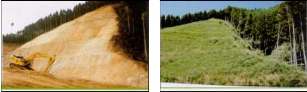
그림 3-1-11. 식물유도뽐어붙이기공법의 시공 전(좌)과 3년 후의 전경(우)
