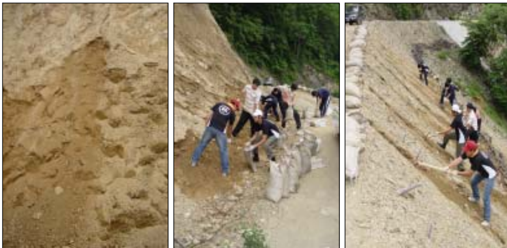
그림 3-4-21. 마대 충전용 토양과 충전 및 시험구 제작 모습
