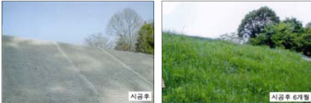
그림 3-1-13. 생분해형 식생시트공법의 시공 전(좌)과 6개월 후의 전경(우)
