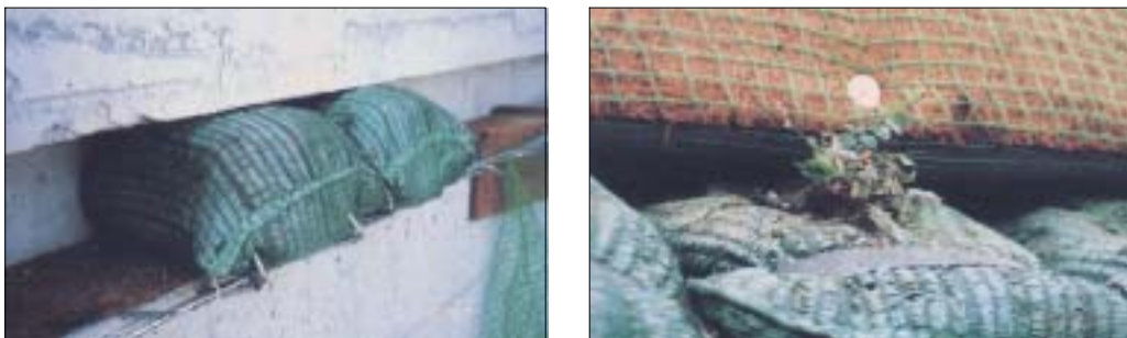
그림 3-1-7. 사방댐 벽면의 식생자루 설치상태(좌)와 포트묘 식재(우)
