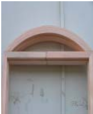
Photo 5-16 만곡 집성재를 이용한 문틀의 제작(레조시놀-페놀공축합수지 사용)
