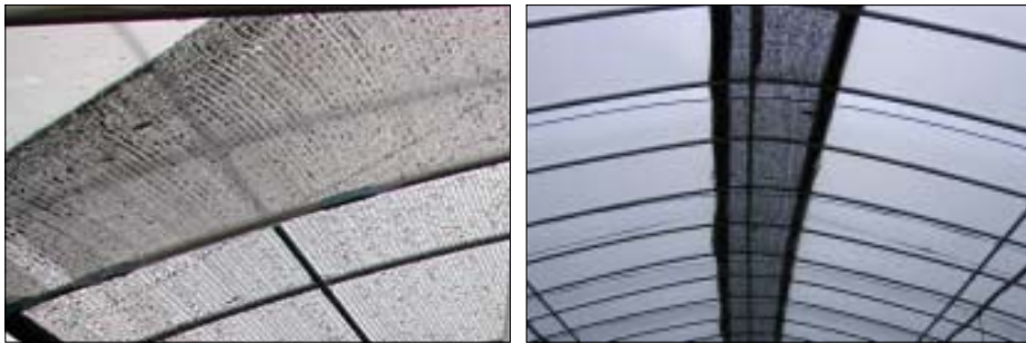
그림 4-3. 고온 피해를 방지를 위해 온실 안(좌)밖에 설치한 천정 차광시설
