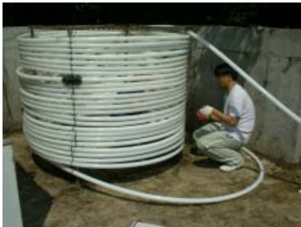
2. 바이오매스 열교환기 배관 조립
