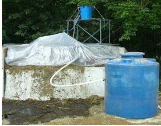
8. 바이오매스 열교환기 설치 완료 모습
