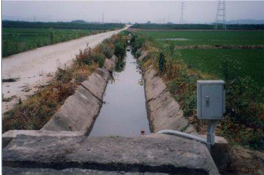
(그림 5-7) 이문양수장지구 용수지거 수위계 설치 전경
