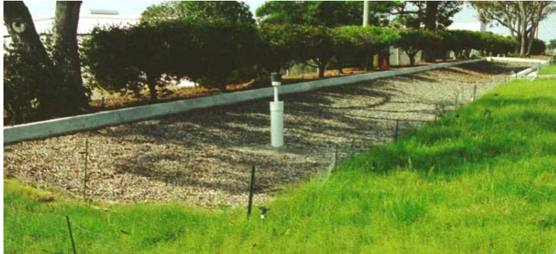
(그림 7-28) 미국 캘리포니아 고속도로에 건설된 침투도랑
