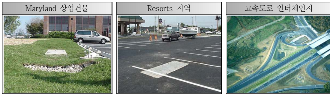
(그림 7-37) Stormfilter 적용사례
