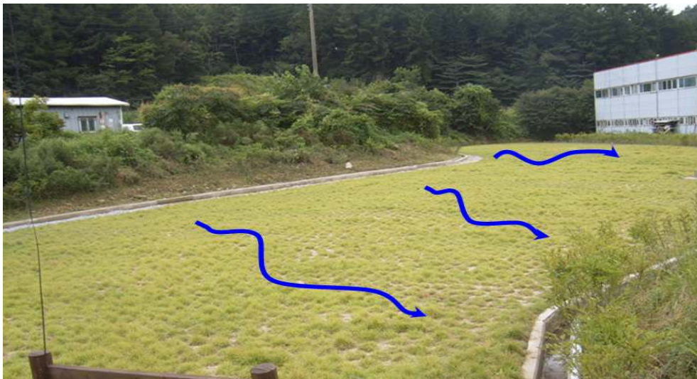
(그림 7-10) 수직방향으로 설치된 식생여과대
