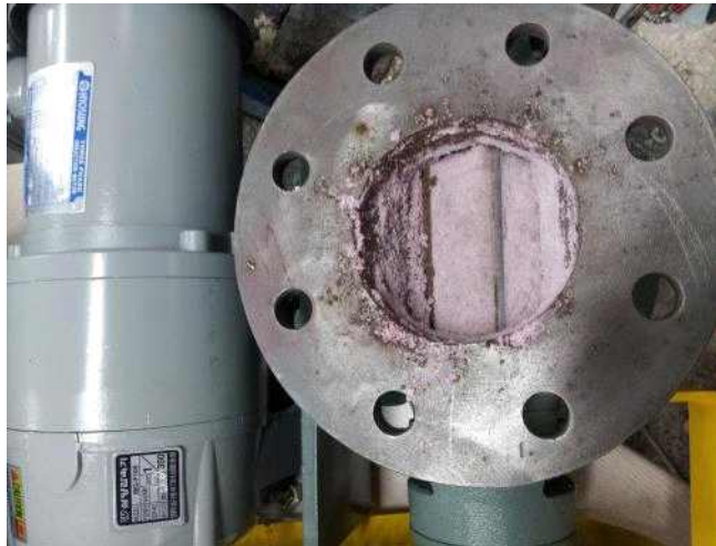
그림 23. 로타리밸브가 부적절하게 작동한 모습.
