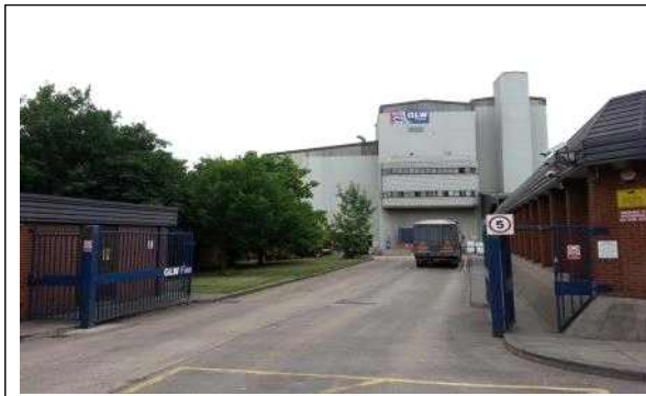
GLW사 출입문 설치 및 출입구 소독시설 미설치
