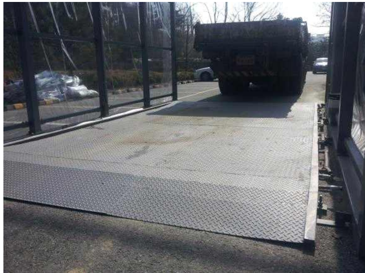
그림 7. 트럭에 의한 침수조 변형 모습.
