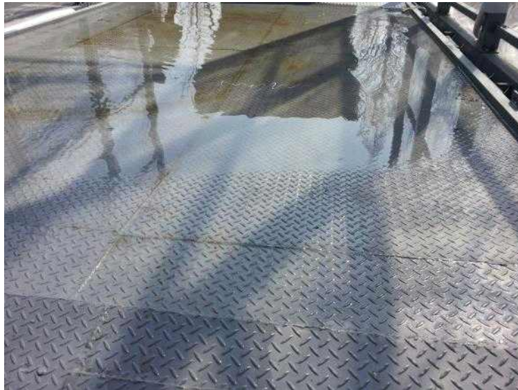
그림 6. 트럭에 의한 침수조 바닥의 변형 모습.
