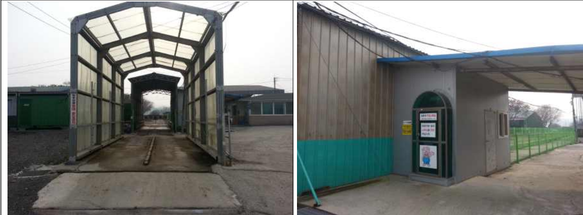
M 양돈장 입구 방역안내문과 차량 이동차단기(1차) → 터널형 자동차량소독기(2중 설치)와 차량 이동 차단기(2차) → 농장 출입문(3차) ※ 사무실 및 주차장은 농장 외부설치, 농장 출입자는 출입기록부 작성 후 대인소독기를 통과 하여 울타리 이동 동선을 따라 이동
