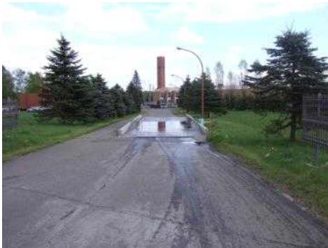
<그림 8> 차량 바퀴 소독을 위한 trench (침수조)
