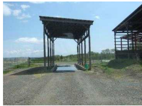
<그림 8> 차량 바퀴 소독을 위한 trench (침수조)
