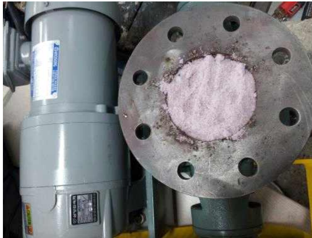
그림 21. 로타리밸브에 삽입된 고체소독제.
