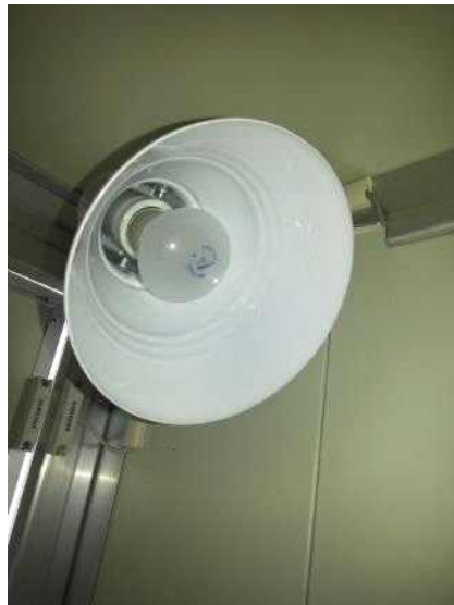
그림 11. 대인대물소독장치의 동결방지용 백열등 설치 사진.
