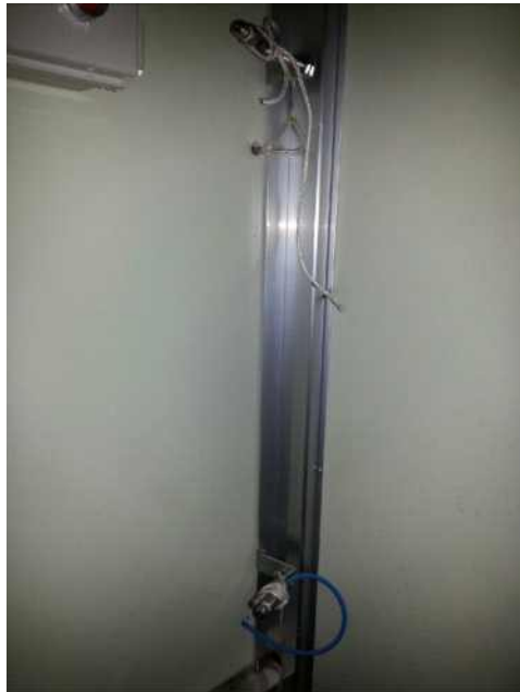
그림 7. 대인소독조 내에 설치된 일류체 오존수 분무 노즐.
