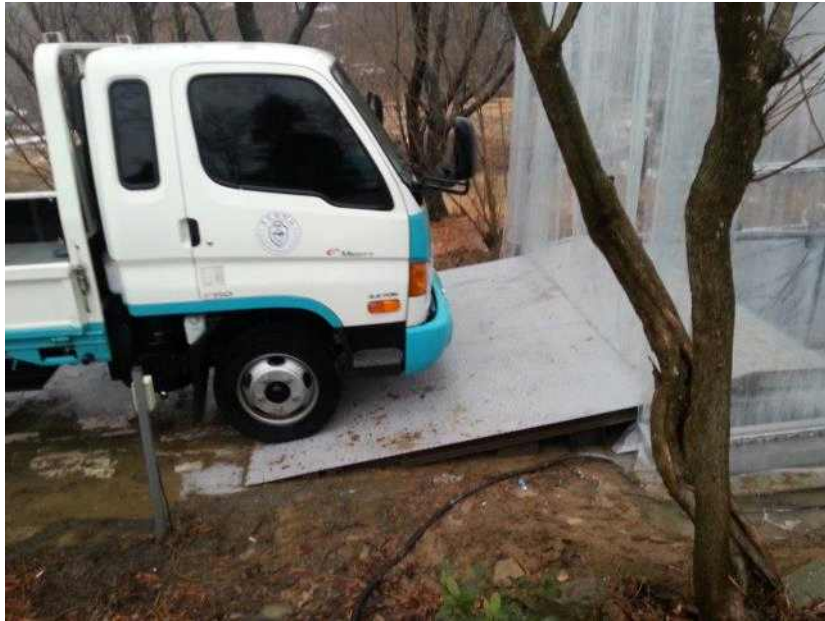
그림 8. 도로경사에 의하여 침수조 턱이 높아진 모습.
