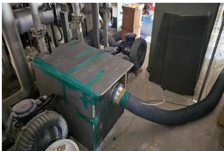
[그림 205] 누출이 발생하고 있는 Blower에 챔버 제작 사진
