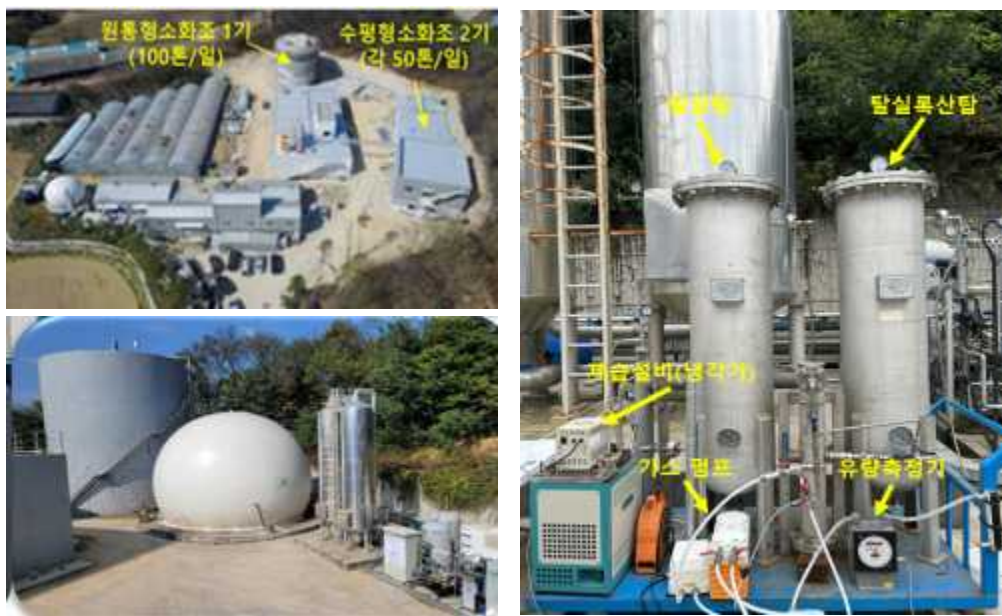
(a) 바이오가스 플랜트 실증부지 (b) 바이오가스 정제시스템 구축 사진
