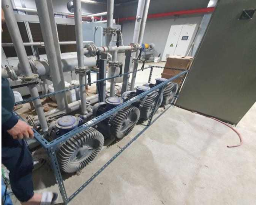
[그림 204] 누출이 발생하고 있는 Blower 부분 사진
