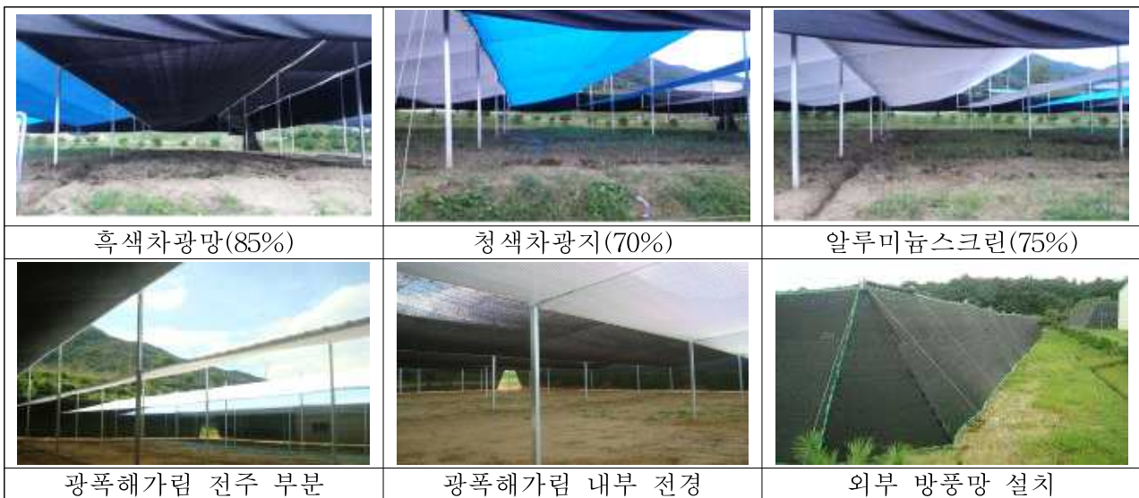
그림 13. 광폭해가림 내 차광재 설치 전경
