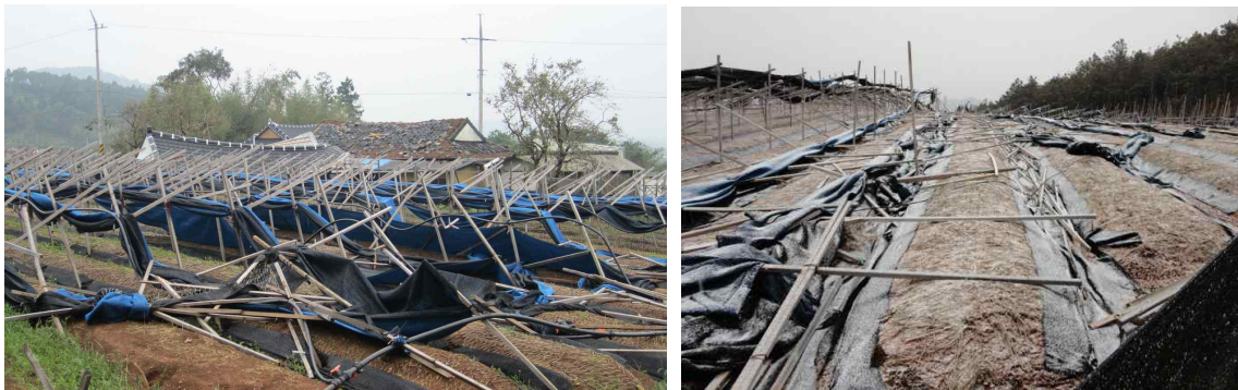
그림 1. 강풍으로 인한 인삼재배시설의 피해사례
