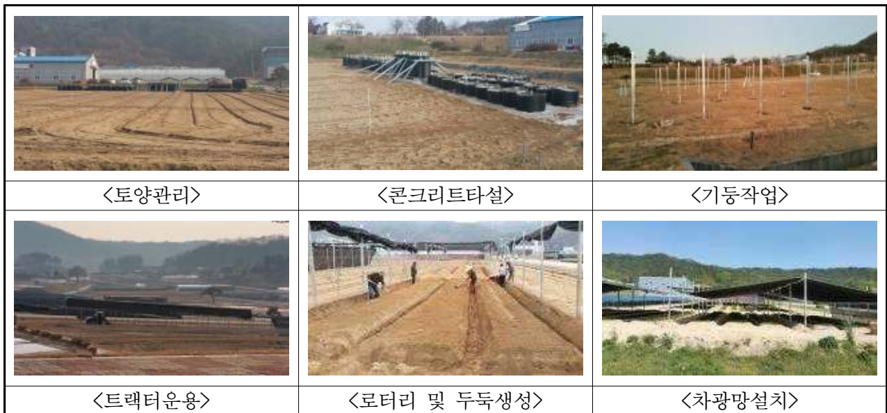
그림 29. 지붕식 광폭해가림시설 설치 작업과정
