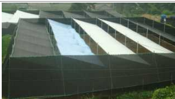
차광재 설치 후 전경
