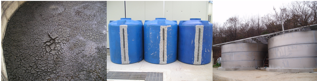
그림 11. 침전층이 형성된 액비탱크 및 액비저장탱크
