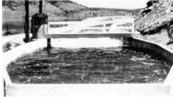
Figure A4-4-4 감쇄장치 설치 후 파살플룸
