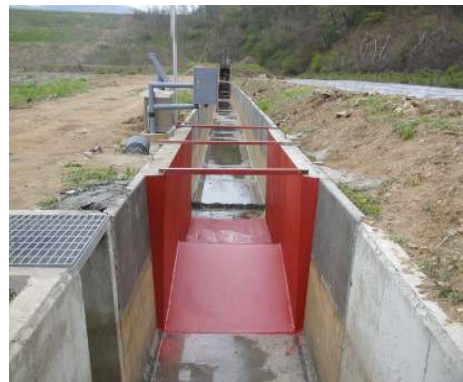
(f) 공사 완료
