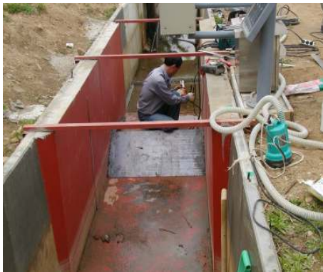
(c) 용접 작업
