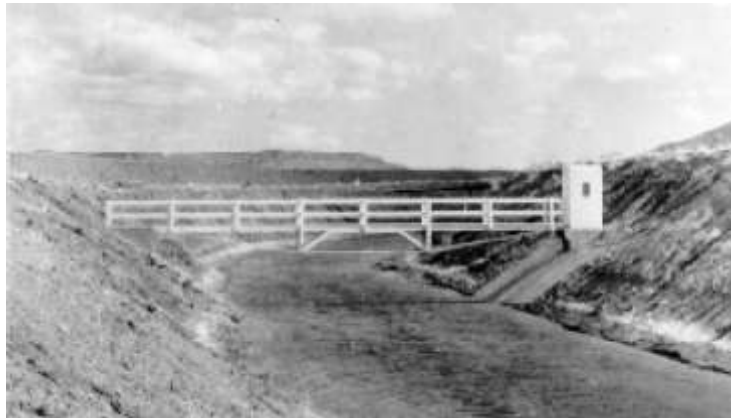
Figure A4-6-1 상류에서 바로 본 수위관측소(유속의 측정은 교각위에서 진행하며, 우측 수위관측소에서 자동수위기록계로 수위를 측정)
