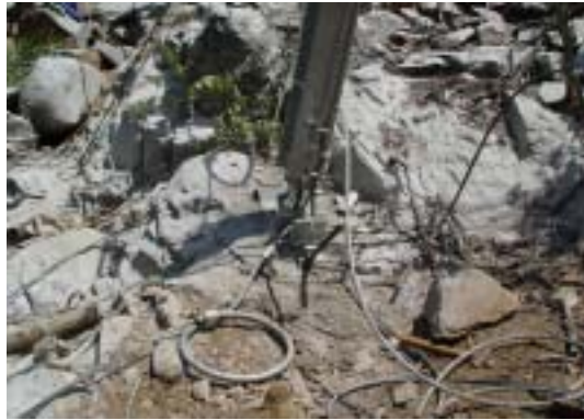
<그림 3-1-52> 지주하부를 시멘트 그라우팅한 모습
