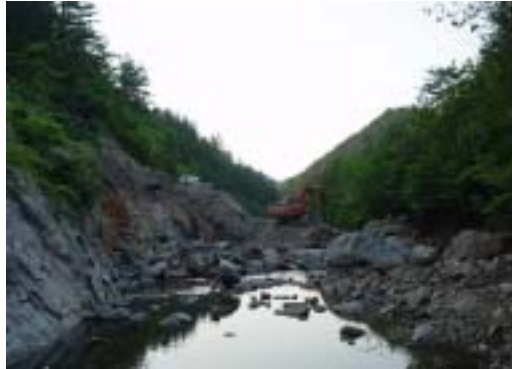
<그림 3-1-41> 진입로 개설 및 댐 시공위치
