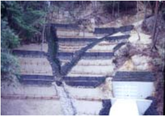
<그림 3-1-16> 자연친화적 복구공법 시공전경
