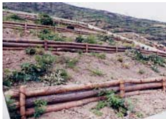
<그림 3-1-25> 불탄나무 편책공 시험구 전경
