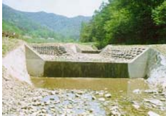
<그림 3-1-8> 콘크리트 바닥막이
