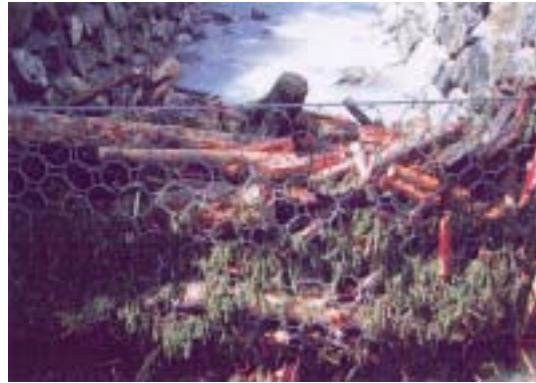
<그림 3-1-44> 링네트에 토석이 저류된 상태 <그림 3-1-45> 링네트에 유목이 저류된 상태
