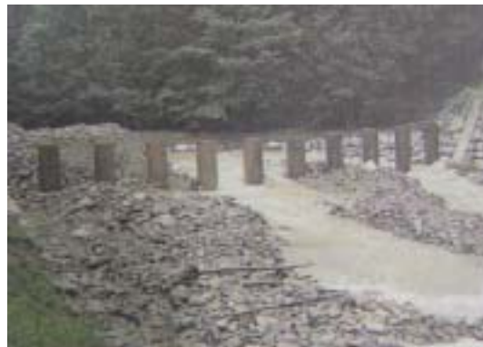
<그림 6-1-6> 2미터 간격으로 설치한 원형철관 스크리트댐
