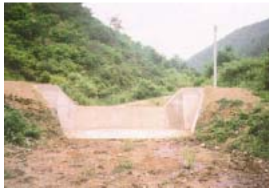
<그림 3-1-12> 콘크리트 골막이
