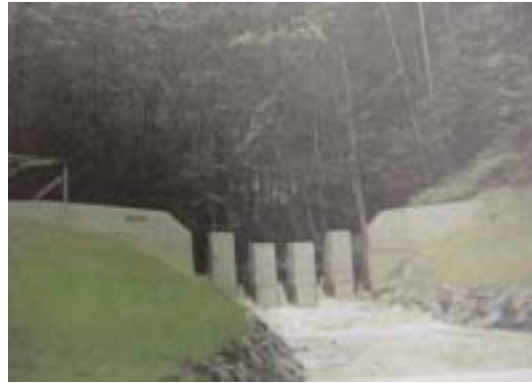
<그림 6-1-8> 상류에 설치된 콘크리트 스트리트댐
