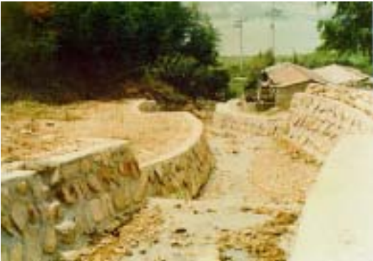
<그림 3-1-9> 돌기슭막이(철쌓기·流路工)
