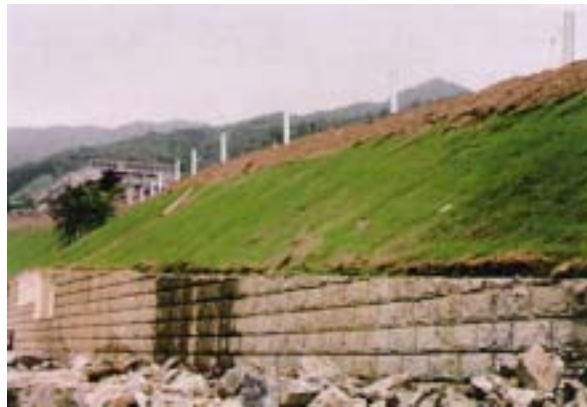
<그림 3-1-2> Coir net를 이용한 분사식 씨뿌리기
