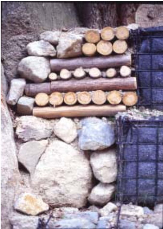
<그림 3-1-18> 돌과 간벌재를 이용한 모습
