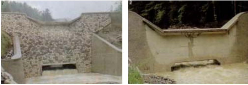
<그림 3-1-37> 어도일체형 사방댐 시공사례
