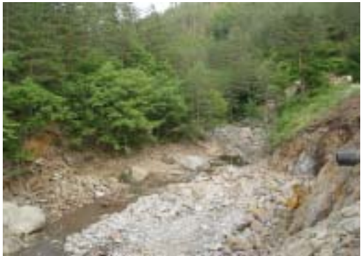
<그림 3-1-42> 계류 양안의 터파기한 모습
