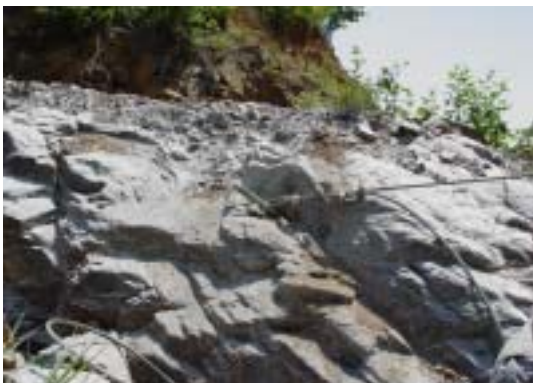
<그림 3-1-53> 사면 와이어로프 고정상태
