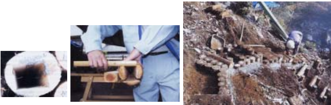
<그림 3-1-15> 간벌재 콘크리트 충전공과 시공 전경
