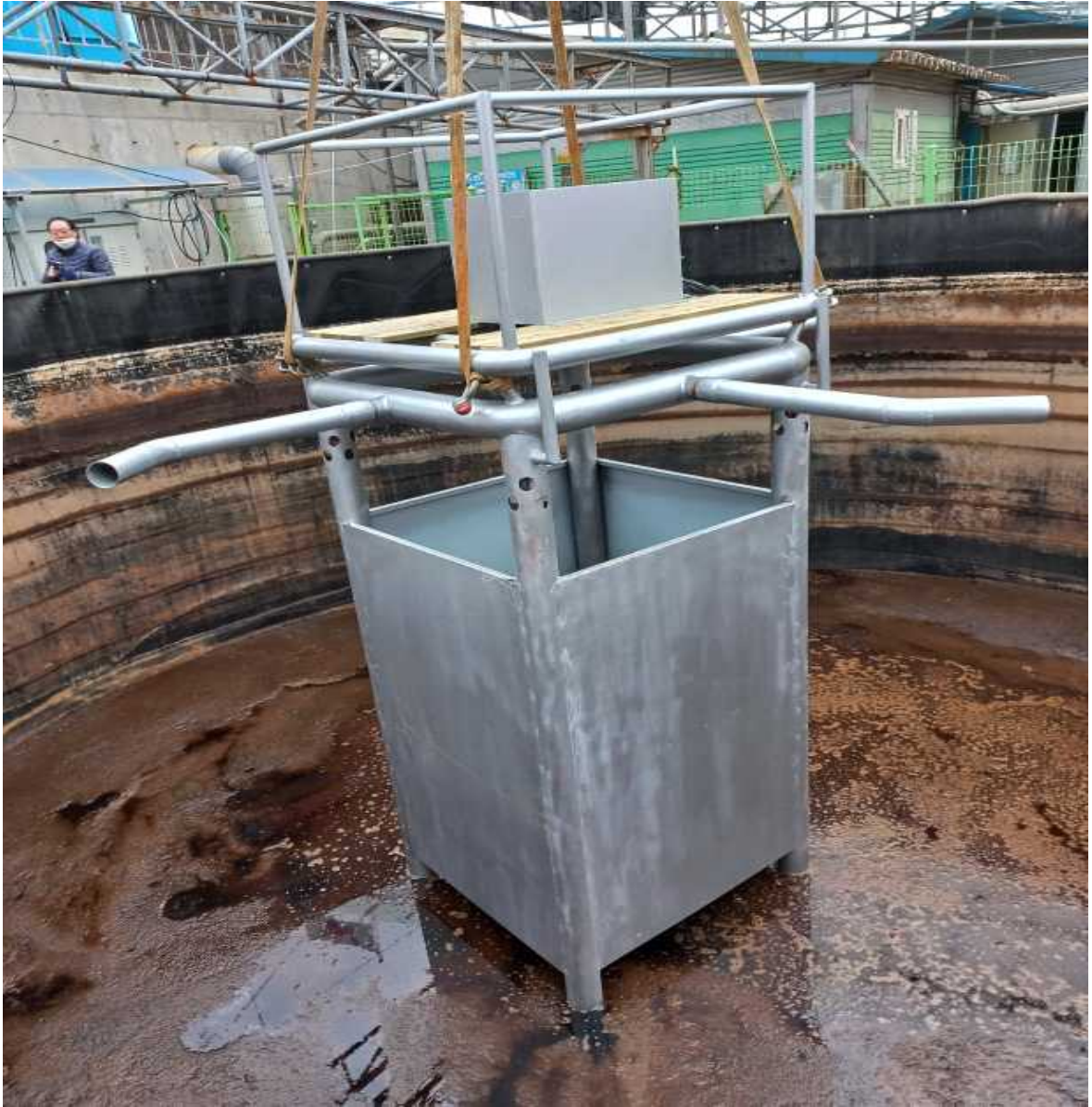
[그림 50] 200톤 정화조 시제품 시공 장면
