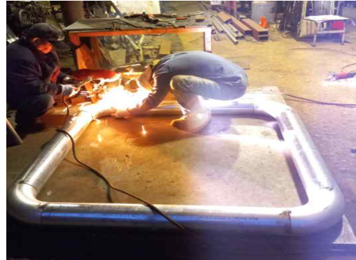
㉡ 측면 하부 분사공 및 거품제거용 홀 설비
