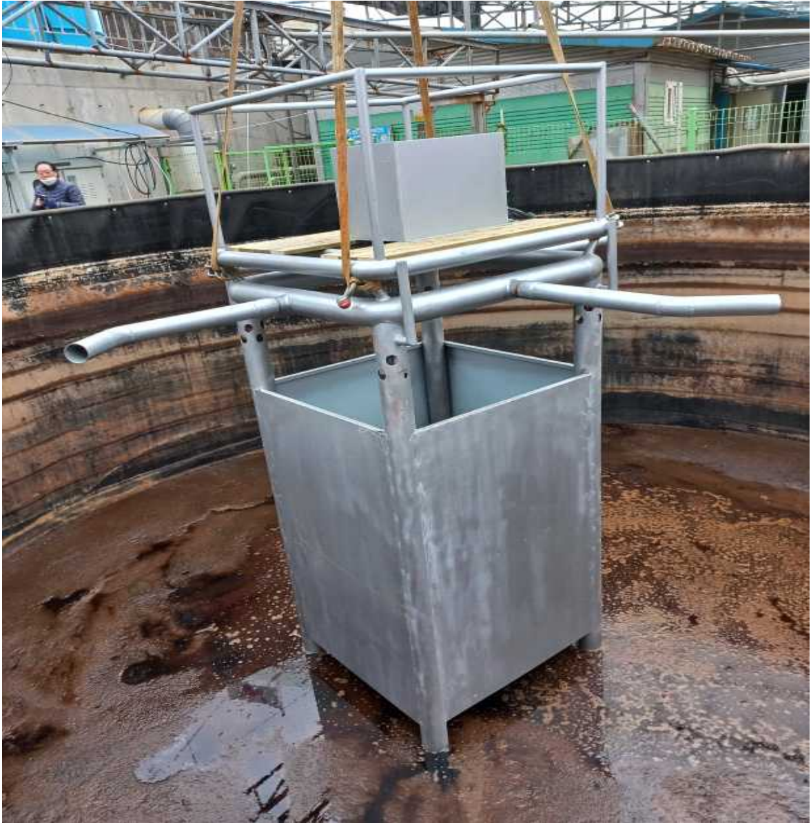
강원도 춘천시 신동면 팔미리 489번지 차돌농장 설치
