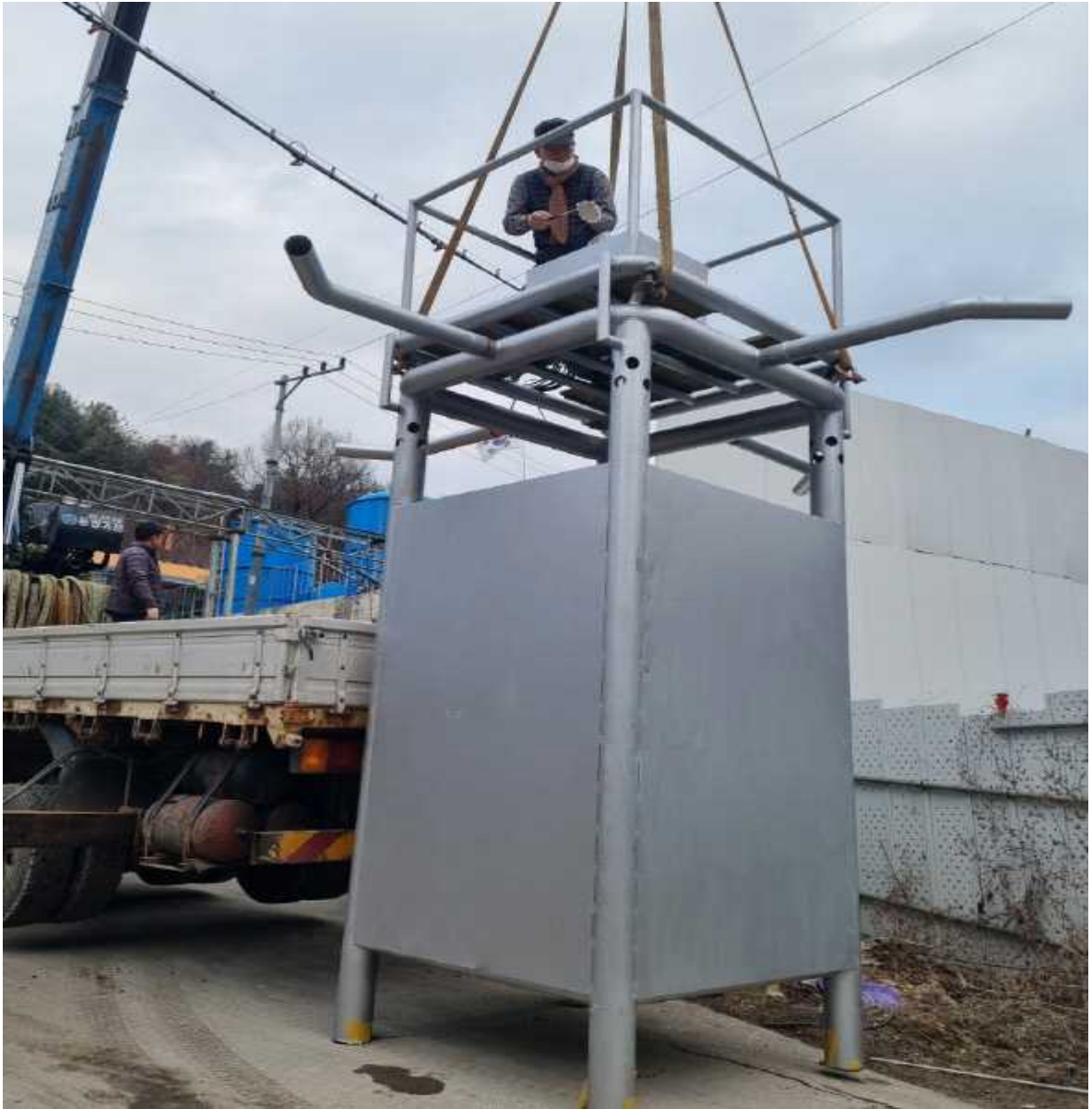
[그림 49] 200톤 정화조 시제품 투입(1.5×1.5×4.5m), 강원 춘천시 차돌 농장: 수직 파이프형 밀폐식 폭기장치 시공 장면
