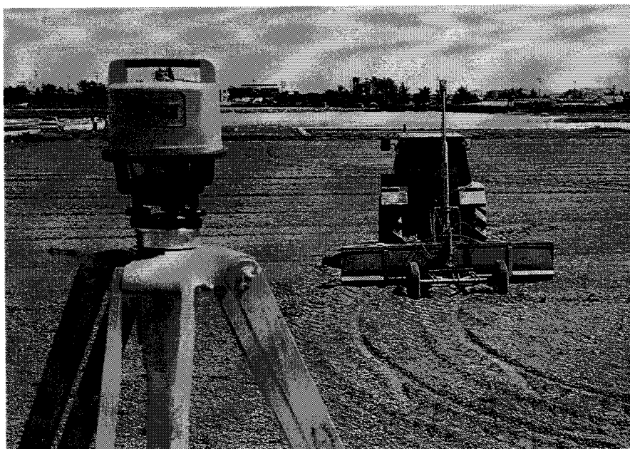
〈 레이저 균평기를 이용한 논균평작업 〉
