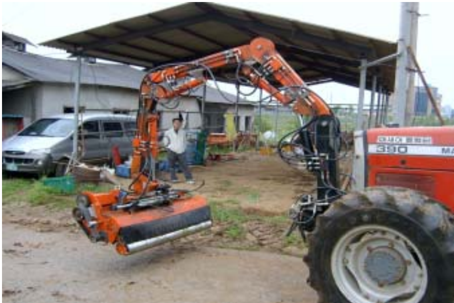
그림 35 View of complete hydraulic pipe laying
