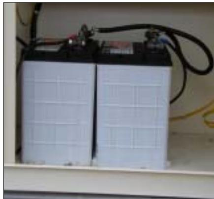
사진 3.7.3 내장 배터리
