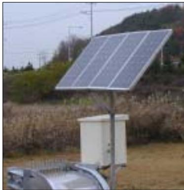
사진 3.7.2 제진기 부착 Solar cell
